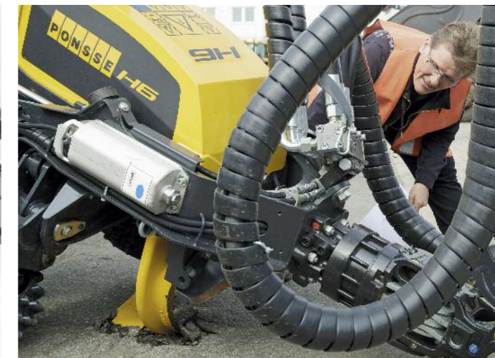
Das Hafenspersonal hat mit dem Greifer den Asphalt aufgerissen, das Aggregat blieb heil.
